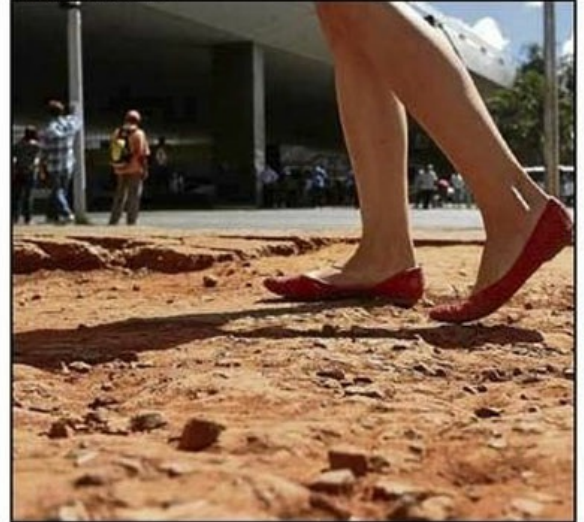
Na Rodoviária do Plano Piloto terra e cimento esburacado nas calçadas
