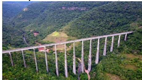
VIADUTO 13 Ferrovia do Trigo Vespasiano Corrêa/RS
