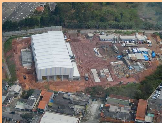
Unidade de Tratamento de Resíduos dos Serviços de Saúde (UTRSS)
