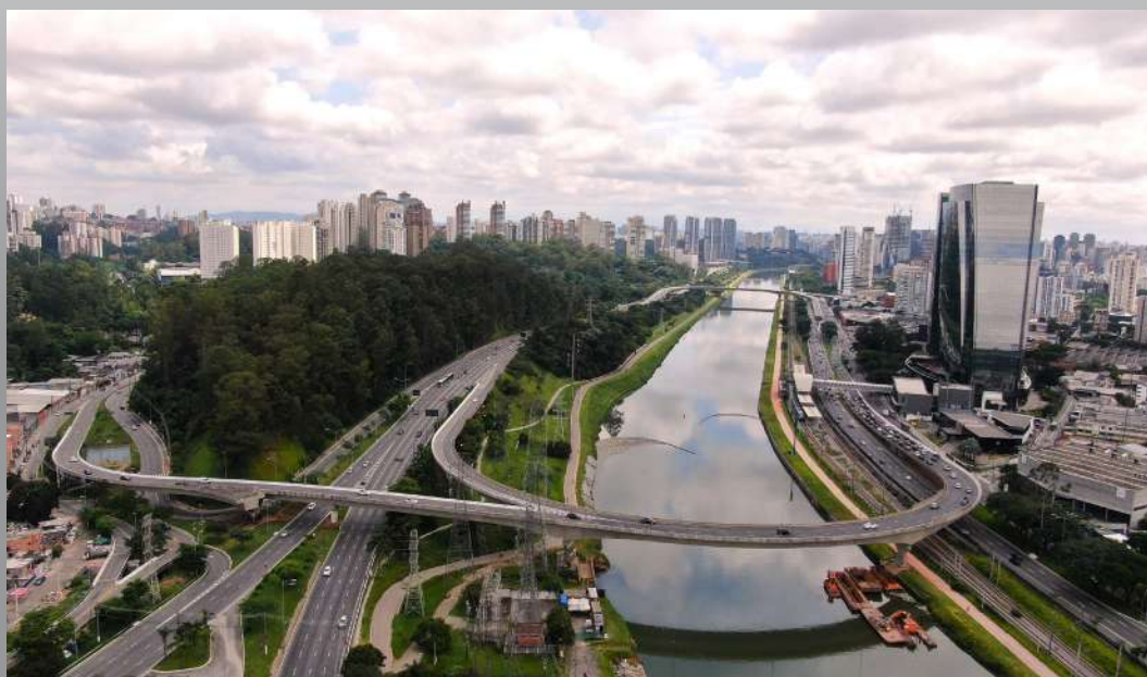
PONTE EDSON GODOY BUENO – ANTIGA PONTE ITAPAIÚNA
