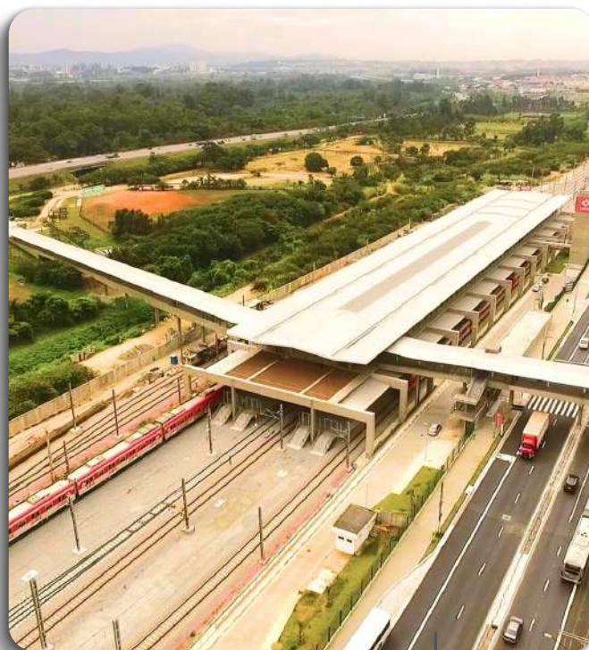
Supervisão das Obras Civis da Linha 13 - CPTM
