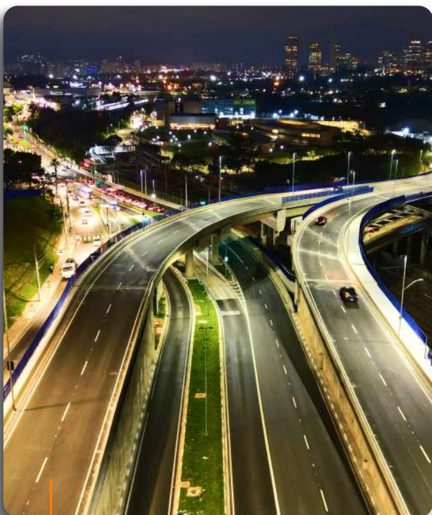
EMTU - VIADUTO CARAPICUIBA
