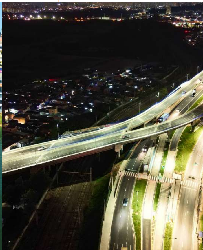
EMTU - VIADUTO CARAPICUBA
