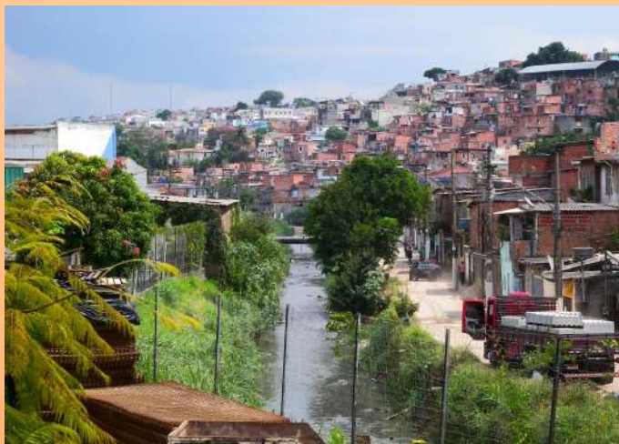
Córrego Ponte Baixa (Sabesp)
