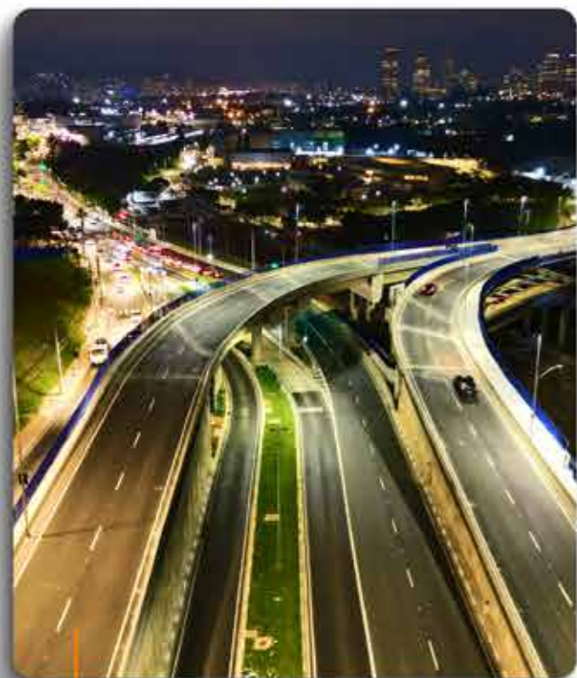
EMTU - VIADUTO CARAPICUBA
