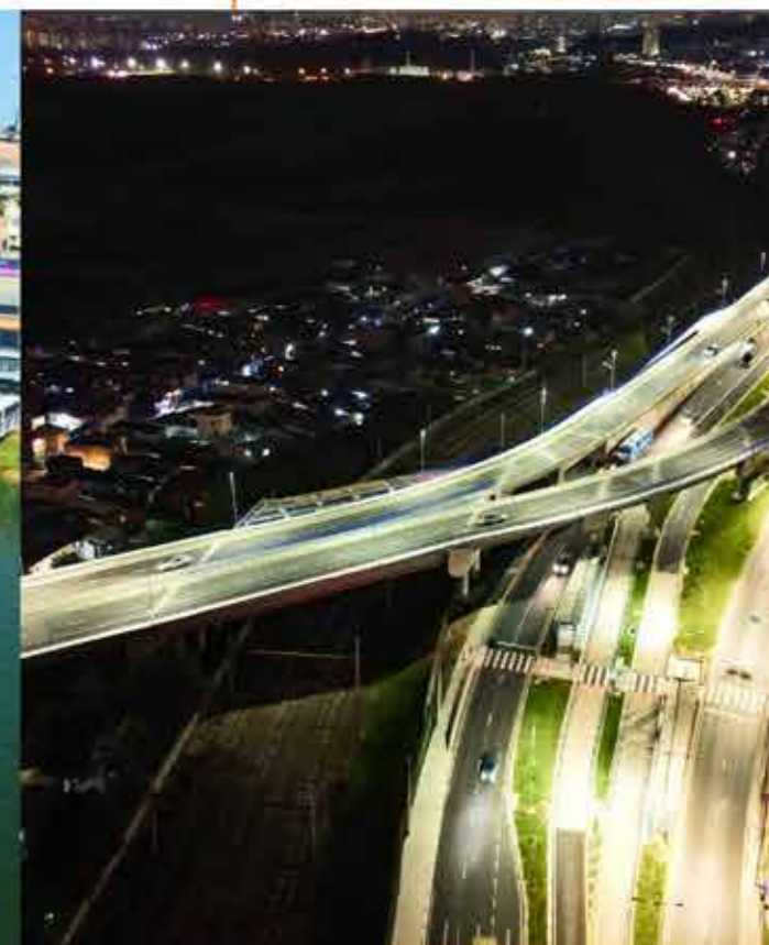
EMTU - VIADUTO CARAPICUBA
