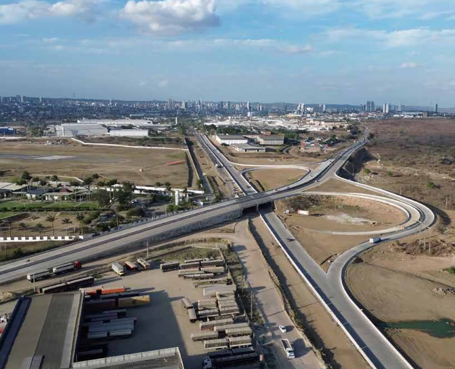
Supervisão Rodovia BR-230/PB
