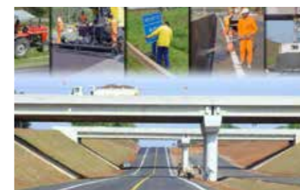
Transporte Rodoviário - DER-SP
