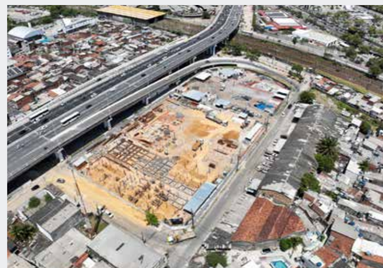
Obras do Conjunto Habitacional São José, na Vila do Papel - bairro de São José, Recife-PE. Imagem: Luiz Recena/TPF Engenharia
