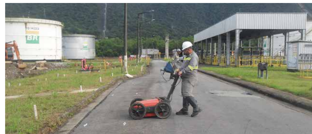
MAPEAMENTO DE INTERFERÊNCIAS DE SUBSOLO COM GPR
