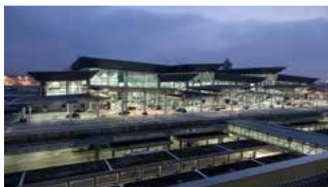
Terminal 3 do Aeroporto de Guarulhos
