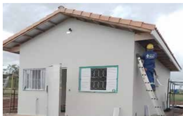
Acompanhamento de obras de novas moradias
