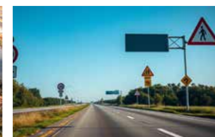
Transporte Rodoviário - DER-SP
