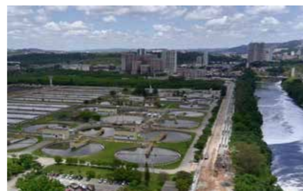
Planta em operação e corpo hídrico de lançamento - Rio Tietê
