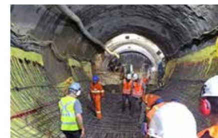
Túnel de Conexão – Metrô SP
