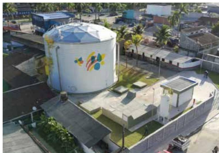
Reservatório Perequê-Mirim - Ubatuba
