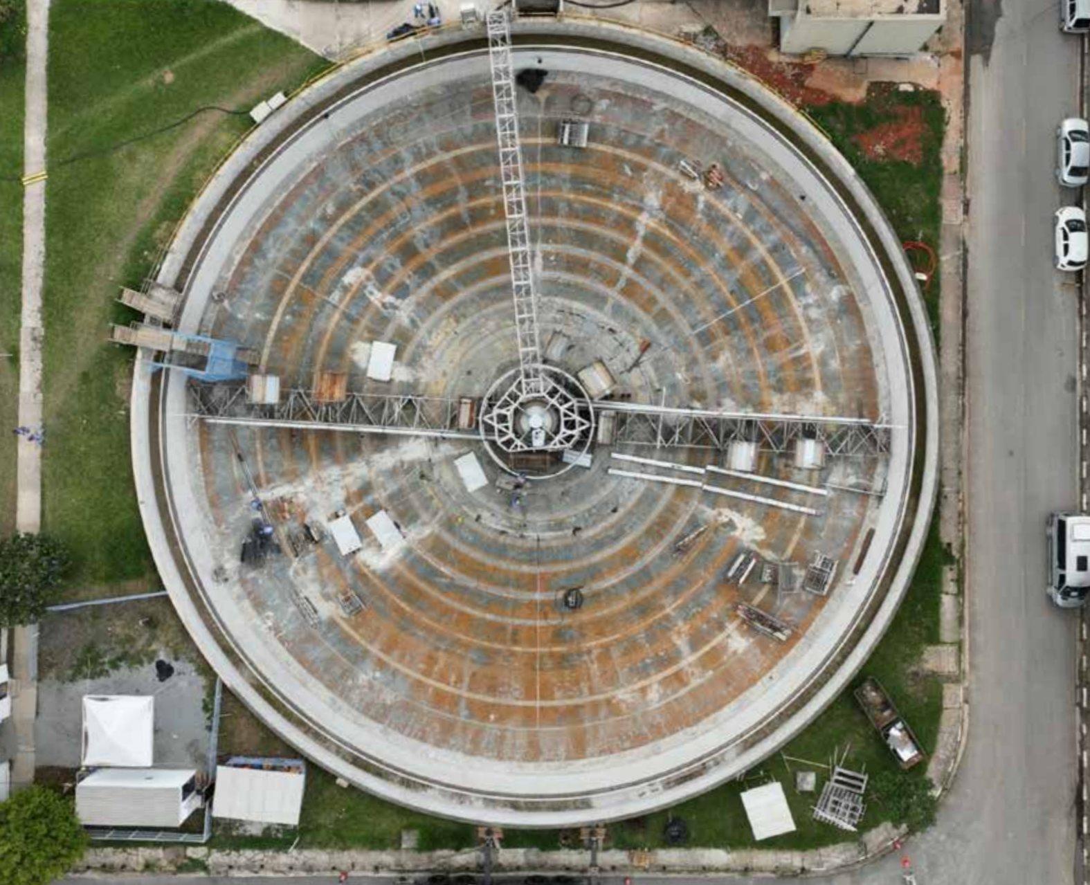
ETE Barueri - Decantador Secundário - Substituição das pontes raspadoras de lodo
