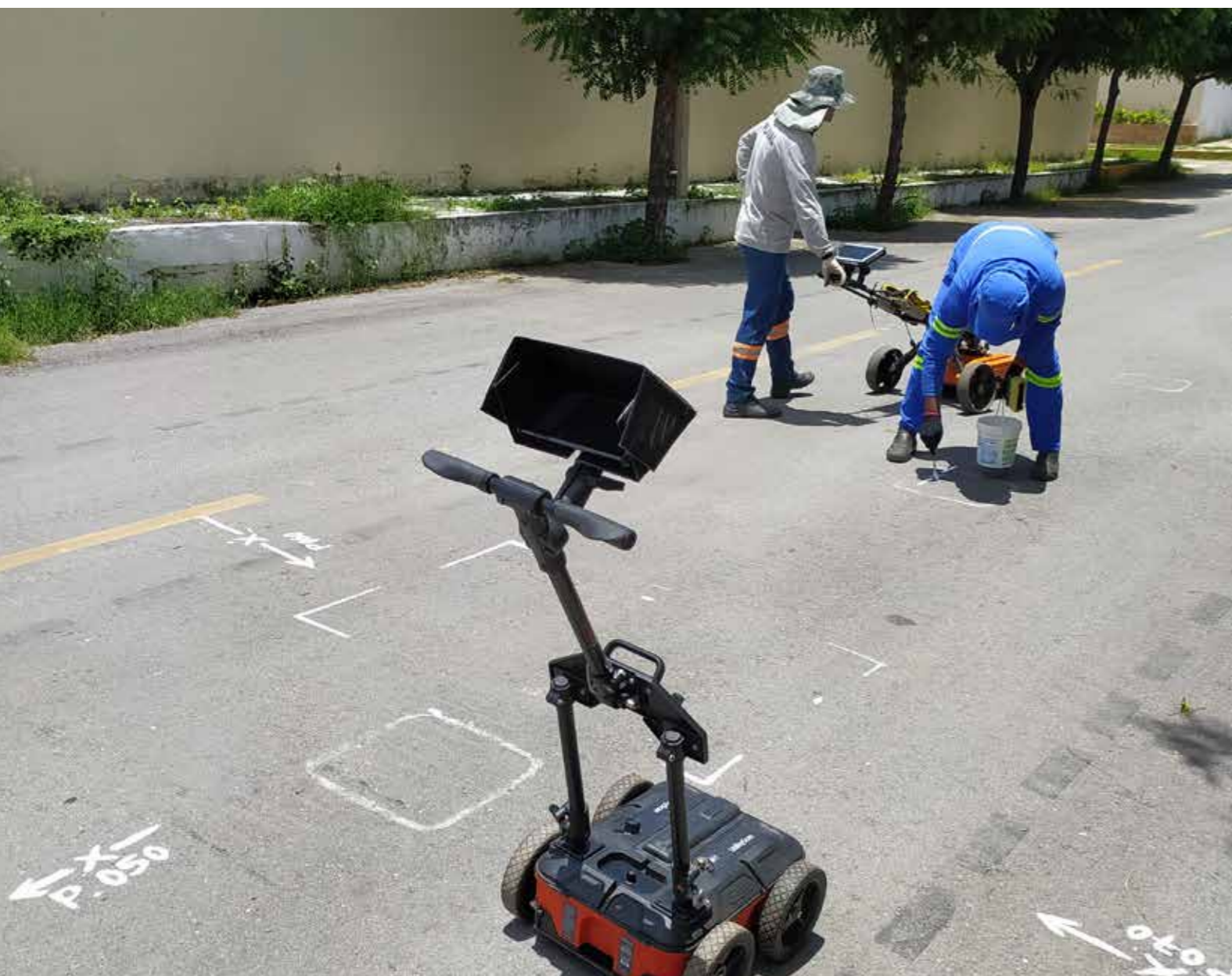
LOCALIZAÇÃO COM GPR DE REDE DE DISTRIBUIÇÃO DE ÁGUA - REDES COLETORAS DE ESGOTO E PLUVIAL
