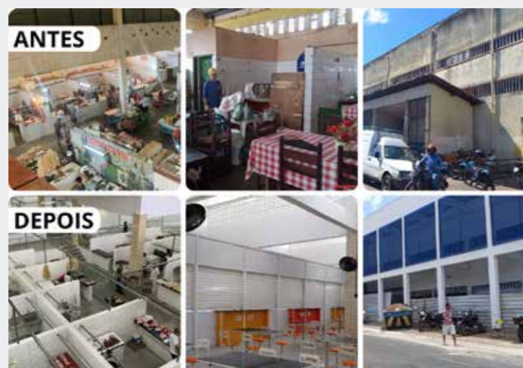
Antes e depois da requalificação dos setores de carnes (à esquerda), restaurante (ao centro) e fachada (à direita).
