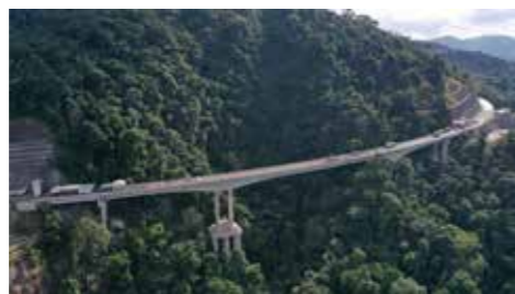
Viaduto V3 da Rodovia Tamoios
