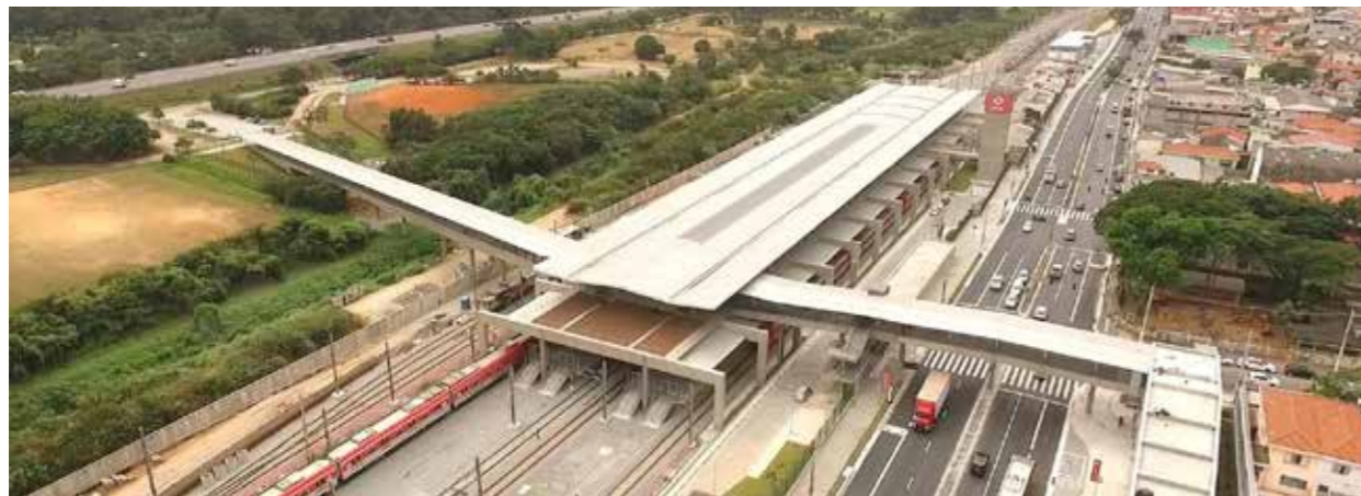
VISTA DA ESTAÇÃO ENGENHEIRO GOULART
